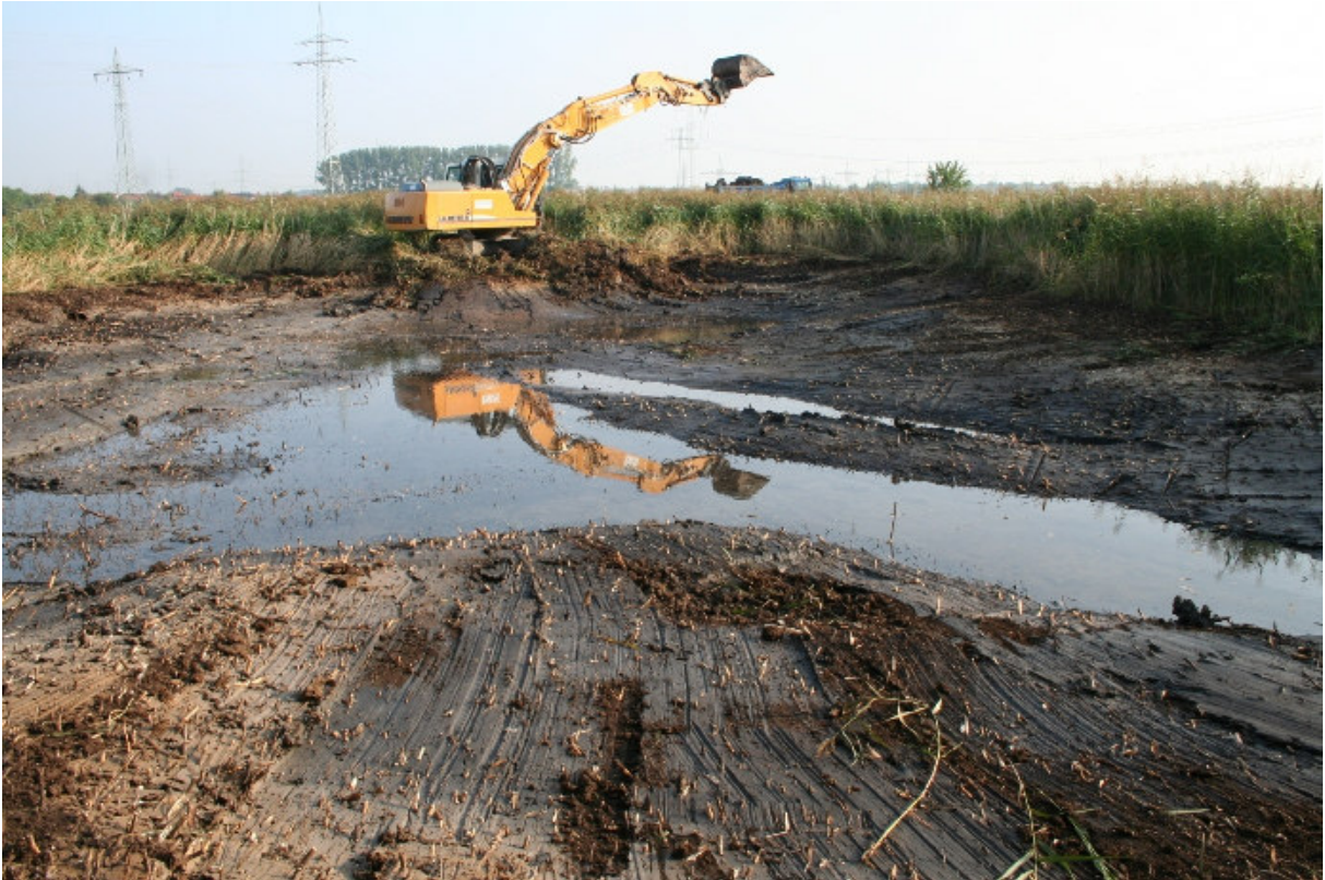
Abb. 17: Anlage eines Flachwasserteichs im Schilf, August 2008 (Foto: G. Bauschmann)
