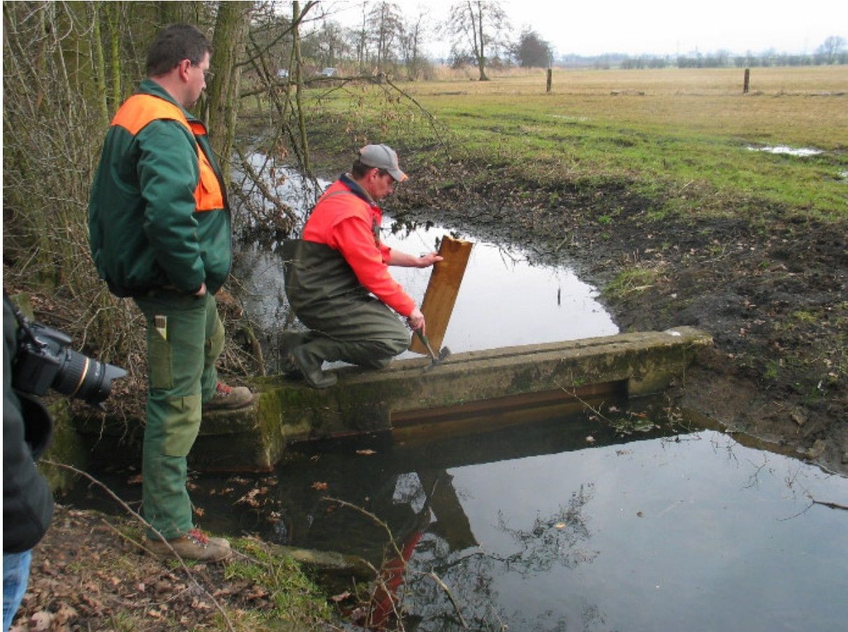
Abb. 19: Probestau im Hechtgraben, Februar 2009 (Foto: G. Bauschmann)
